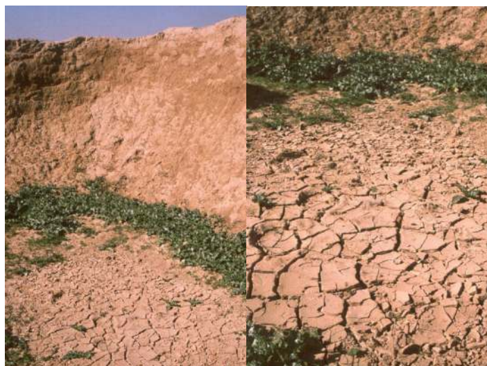
■ اشکال ۳۷ و ۳۸: فرسایش بدنه‌های خشتی بر اثر آب‌شستگی رس‌ها (مأخذ: نگارنده، ۱۳۷۹).
