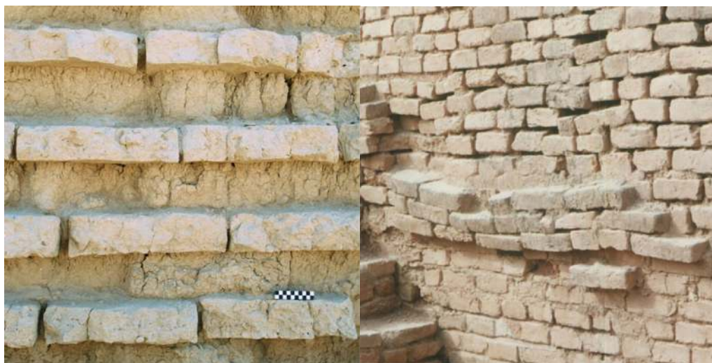
■ شکل ۱۴: اختلاف سطح نمای مرمتی با نمای اصیل / سمت راست (مأخذ: نگارنده، ۱۳۷۹).
