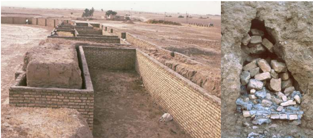
■ شکل ۱۹: نمونه‌ای از پر کردن حفره‌ها در بدنه حصار داخلی / سمت راست (مأخذ: نگارنده، ۱۳۷۸). ■ شکل ۲۰: احداث دیوار آجری جدید در اطراف حصار داخلی / ضلع جنوب غربی زیگورات / سمت چپ (مأخذ: همان).
