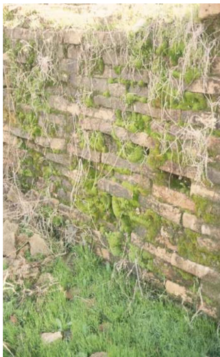
■ شکل ۲۸: پوشش گیاهی متراکم بر سطح و لایه‌های مصالح (مأخذ: نگارنده، ۱۳۷۹).
