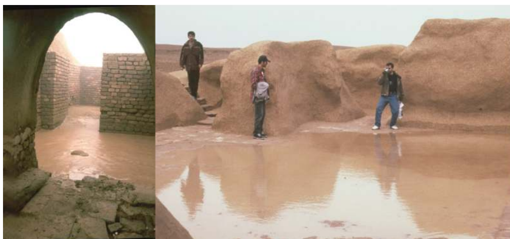
■ اشکال ۳۱ و ۳۲: فقدان نظام مناسب و کارآمد برای دفع آب باران (مأخذ: بایگانی پایگاه میراث جهانی چغازنبیل، ۱۳۷۹).
