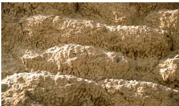
■ شکل ۲۴: بافت فرسایشی موج در بدنه‌های خشتی (مأخذ: همان).
