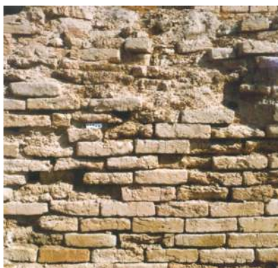
■ شکل ۳۵: روند پر شتاب فرسایش مصالح تاریخی (مأخذ: بایگانی پایگاه میراث جهانی چغازنبیل، ۱۳۷۸).
