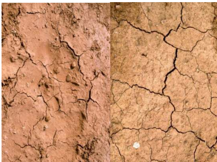
■ شکل ۲۲ (سمت راست): ترک‌های مشبک (مأخذ: همان). ■ شکل ۲۳ (سمت چپ): ترک‌های شعاعی (مأخذ: همان).
