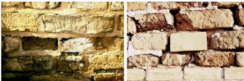
■ شکل ۴۴: تعویض مصالح تاریخی فرسوده با مصالح جدید (مأخذ: پایگانی پایگاه میراث جهانی چغازنبیل، ۱۳۸۰).
