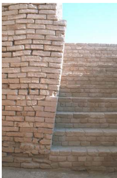
■ شکل ۳۴: برهم خوردن تعادل و ایستایی در برخی ورودی‌های زیگورات (مأخذ: نگارنده، ۱۳۸۰).
