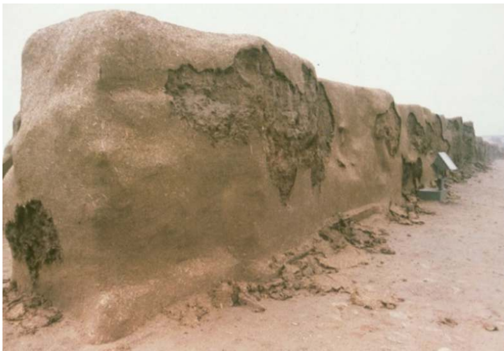
■ شکل ۳۹: جدا شدن اندود کاهگل از روی بدنه‌های ماسه‌ای (مأخذ: نگارنده، ۱۳۸۰).
