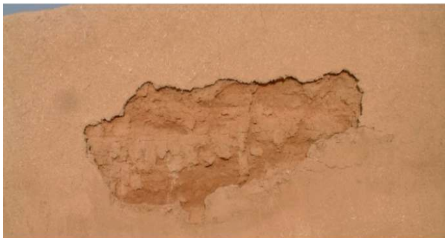
■ شکل ۴۰: جذا شدن اندود کاهگل از روی بدنه‌های شورهای (مأخذ: نگارنده، ۱۳۸۰).
